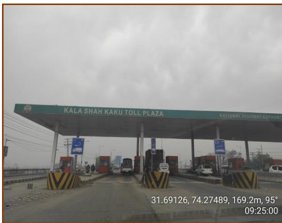
KALA SHAH KAKU TOLL PLAZA (KM. 1275+050)
