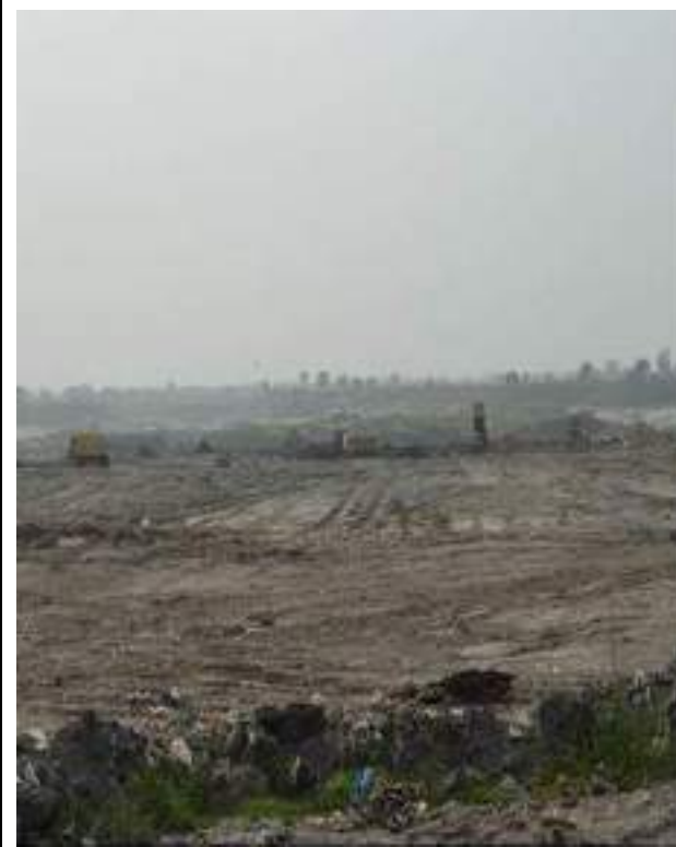
Lakhodher Landfill Site
